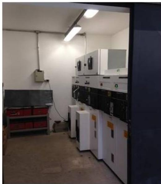
Cubículos novos 20 kv com interligação de retificador e bateria
